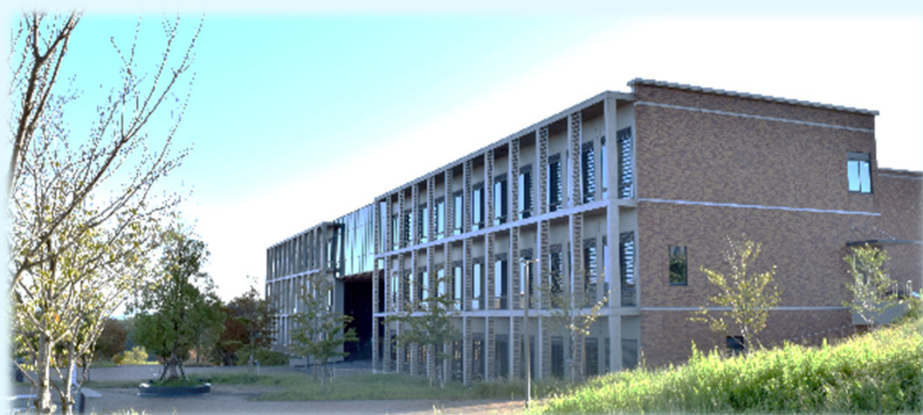
事務管理棟・桂インテックセンター
